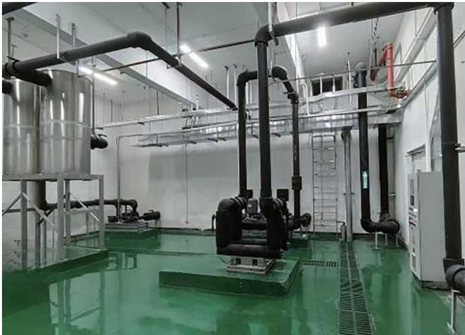
雨水冷凝水回收系统
